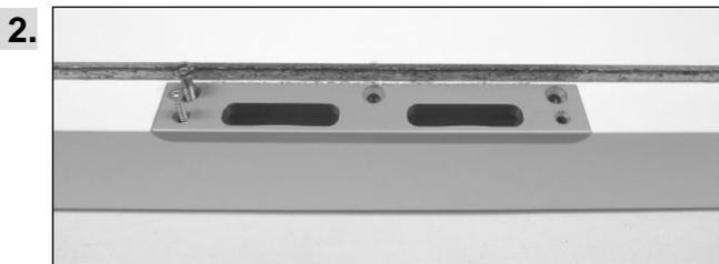
Dichtung auf der Schließblechseite herausziehen und das Massiv-Schließblech losschrauben.
