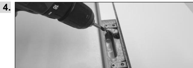
Ist die Zarge in der Wandöffnung lot- und fluchtgerecht montiert, mit einem Bohrer (Ø 8 mm) schräg durch die Längsslitze der Halteplatte in die Wandleibung bohren.
