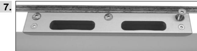
Abschließend das Massivschließblech mit den Schrauben M5 bzw. den Spax-Schrauben wieder festschrauben und die Dichtung einziehen.
