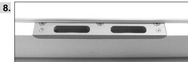
Die Verschraubung wird durch das Schließblech und die Dichtung komplett verdeckt.
