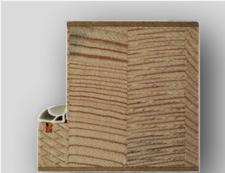
Querschnitt: abgesperrtes Leimholz
