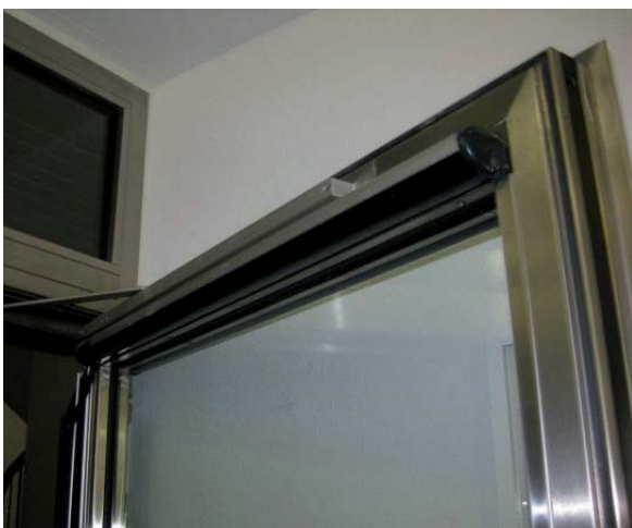
Bild 6 Infrarotvorhangschiene zur Anwesenheitskontrolle
