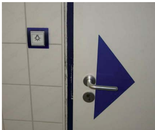
Bild 8 Kennzeichnung von Türdrückern durch einen kontrastreichen Aufkleber
