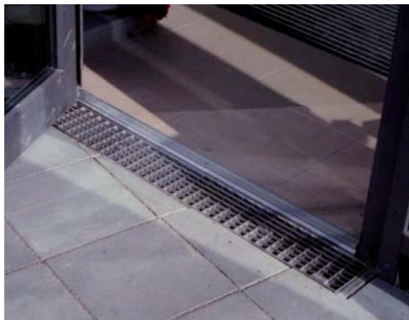
Bild 4 Schwellenfreier Zugang mit Wassersammelrinne und Gitterrost
