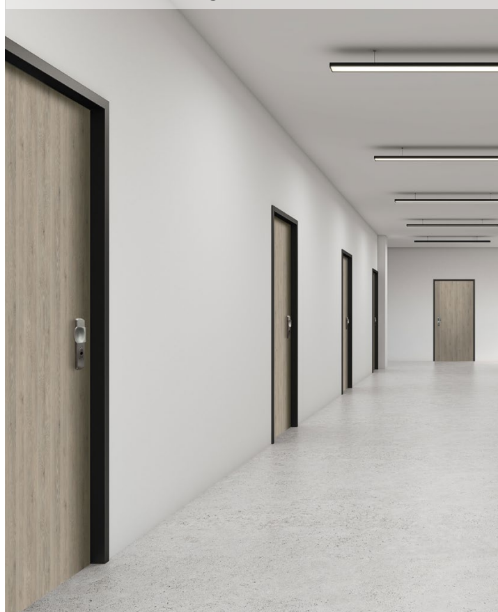
Nach der Sanierung mit unseren RC 2 Türen
